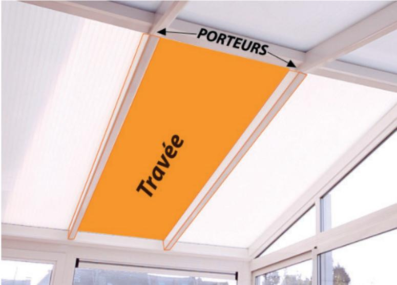
Un toit de véranda est composé de travées soutenues par des porteurs.
